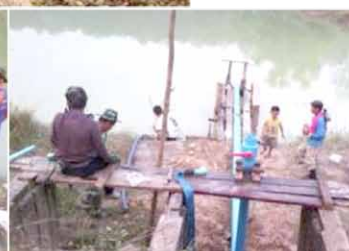
ต่อระบบกาลักน้ำพร้อมใช้งาน
