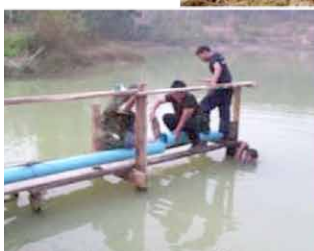
ต่อระบบท่อกับล้นน้ำแล้วเปิดปิดดูน้ำ จากอ่างโดยใช้ท่อ PVC ขนาด 4 นิ้ว
