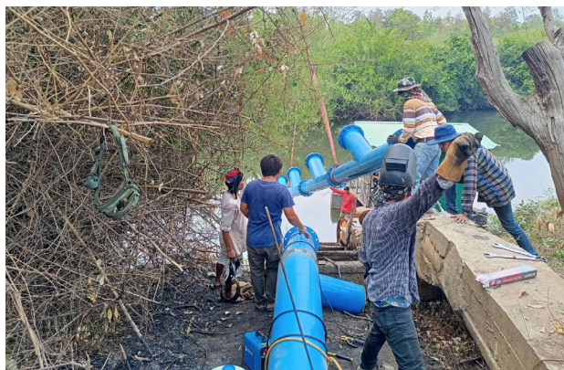
เกษตรกรผู้รับผลประโยชน์ในโครงการฯ ร่วมกันลงมือต่อท่อเพื่อนำน้ำเข้าแปลงเกษตร
