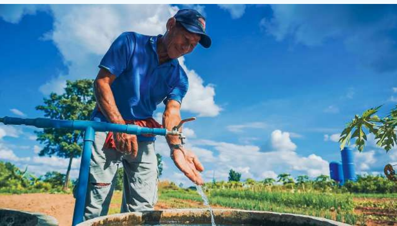
ระบบส่งน้ำส่งตรงถึงแปลงเกษตร
