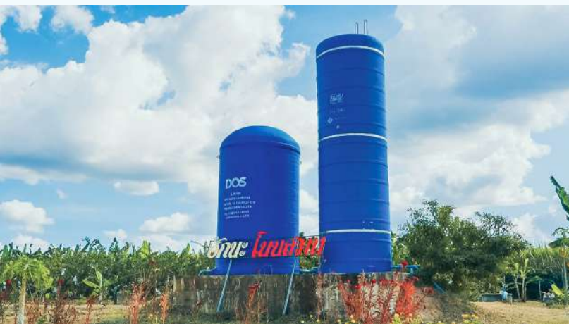
ถังเก็บน้ำขนาดใหญ่
